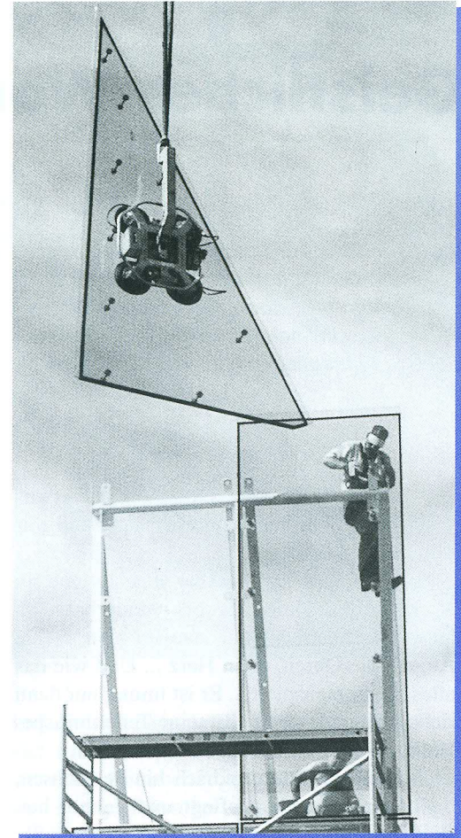
Endlich konnte der Glasturm, der den Innenraum mit Tageslicht versorgt, montiert werden.
