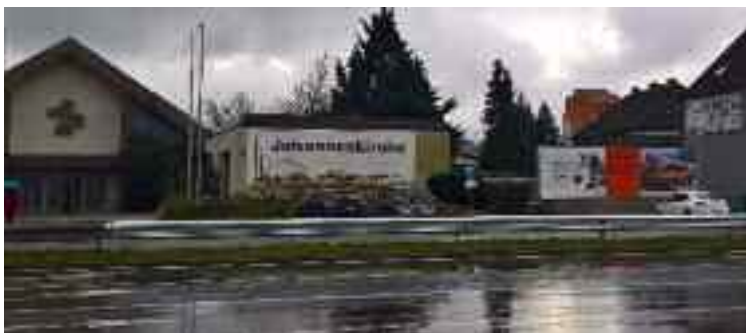
In den vergangenen Wochen haben wir als Pfarrgemeinde Linz-Süd das Grundstück im Westen der Johanneskirche als neuen Lebensraum erworben.
